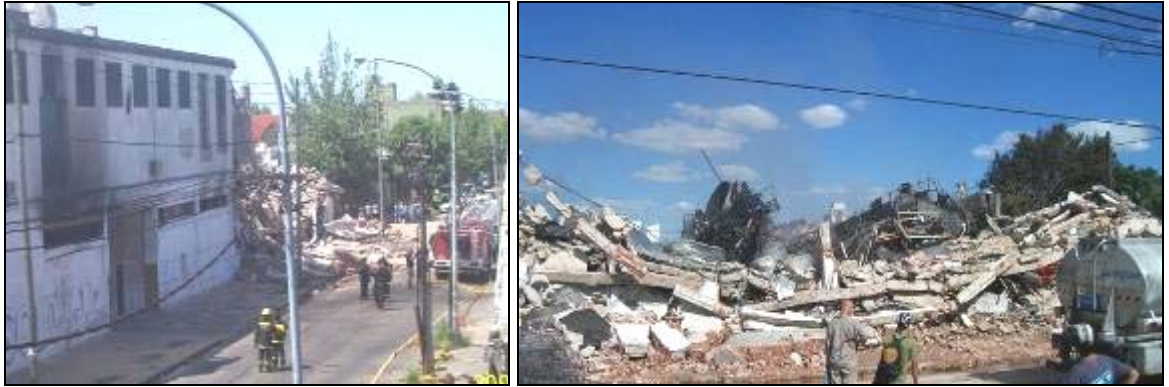
Vistas de los daños al edificio luego del siniestro.
