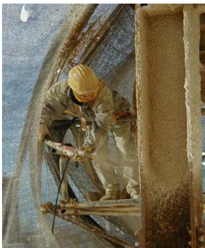
Aplicación de pintura intumescente
