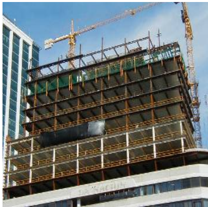
Torre edificio Diario La Nación de Buenos Aires (estructura metálica protegida por mortero liviano para fuego celulósico).
